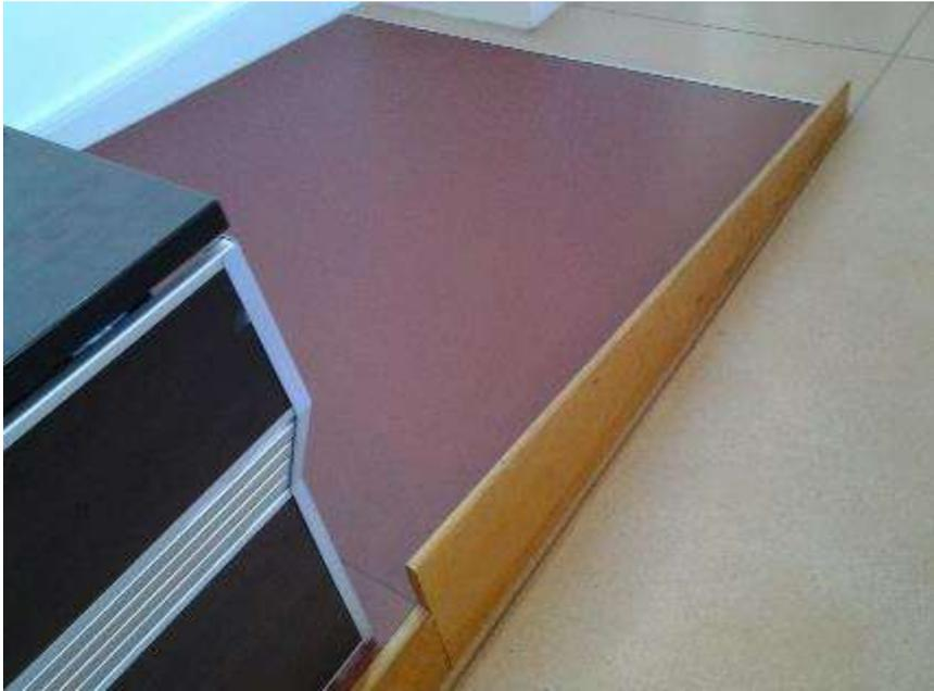
Rampa con protezione laterale molto bassa: è causa di incidenti per tutti.
